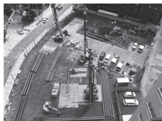
杭打ち作業の状況
