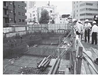
（基礎工事 2016 年 9 月頃）
