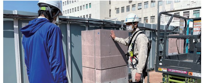
カラーコンクリート テスト施工確認の様子。 様々な実験を行い、最良のカラーコンクリートを目指しています。
